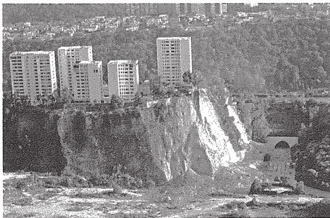
El requerimiento de la delegación plantea, además de la demolición de la vivienda de Rosette, construir un sistema de estabilidad y de anclaje del talud.
